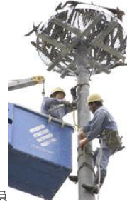
巣となる円盤を電柱の先端に設置する四電工社員
