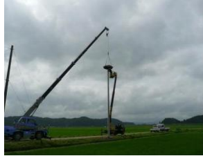
コンクリート柱に巣台が乗せられ完成した
